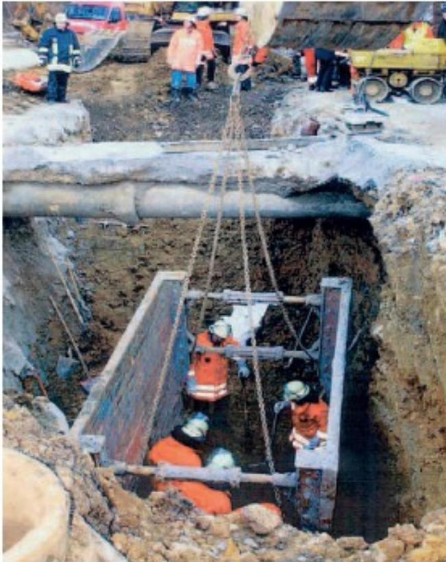
Einsatzmaßnahmen erst durchführen, wenn Sicherungsmaßnahmen gegen den Einsturz von Erdwänden und nachrutschende Erdmassen getroffen wurden. Hier hilft die schnell absenk-
