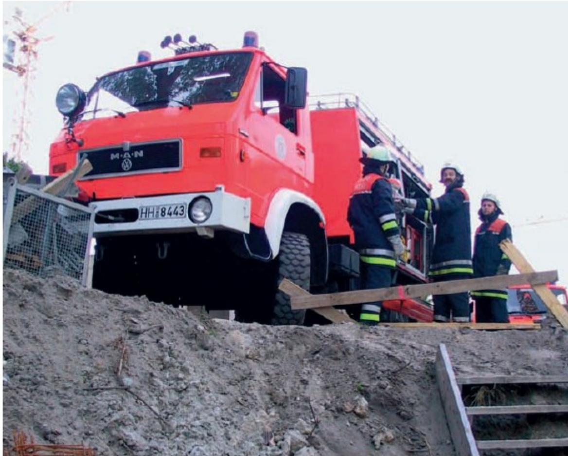
Das unmittelbar an der Baugrube aufgestellte Einsatzfahrzeug bildet eine unnötige und gefährliche Auflast für die Böschungskante.
