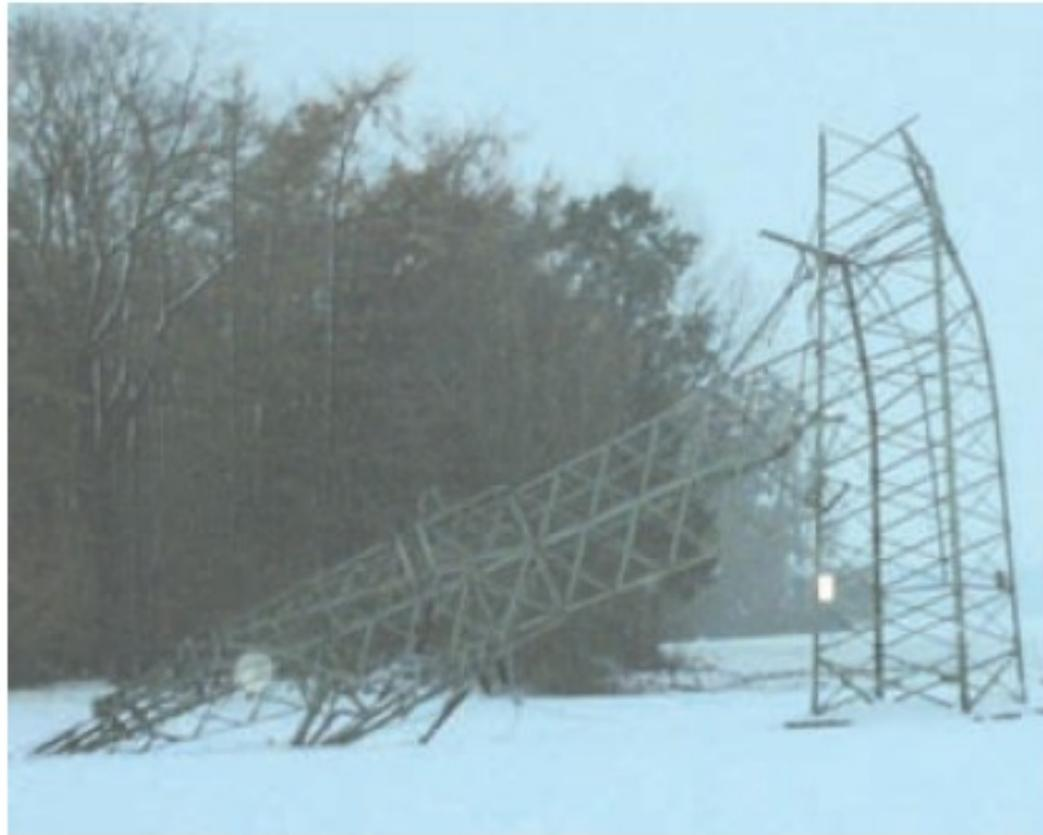
Gefahr: Durch Witterungseinwirkung abgeknickte Leitungsmasten und zerstörte Überlandleitungen
